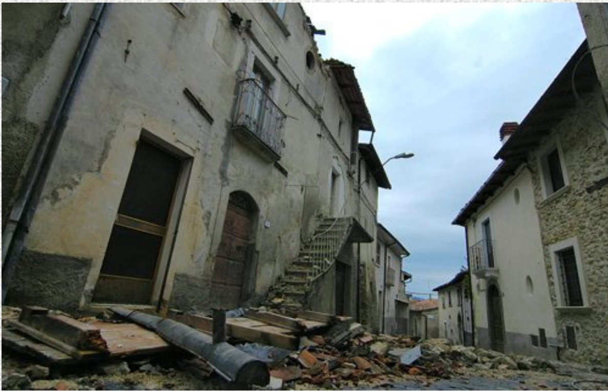
La Frazione di Colle di Lucoli all'indomani del sisma del 2009
